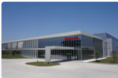
Wuxi Plant, China
