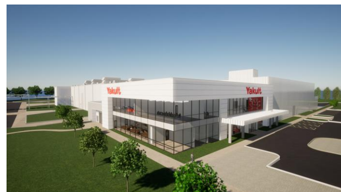
アメリカ第2工場（ジョージア州） 2026年9月稼働予定
