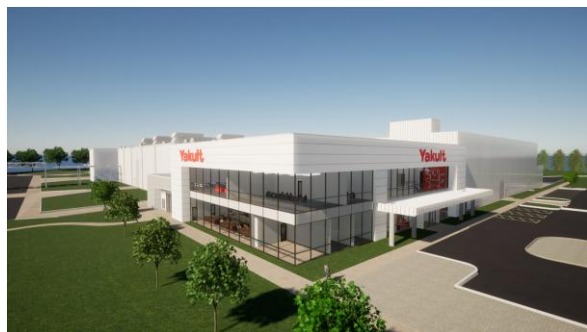
第2工場（ジョージア州）建設中
