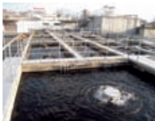
▲佐賀工場の排水処理施設
