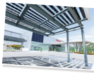
屋根に採光型の太陽光発電パネルを設置し、木漏れ日を連想させる駐車場
