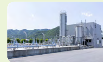
排水処理施設
