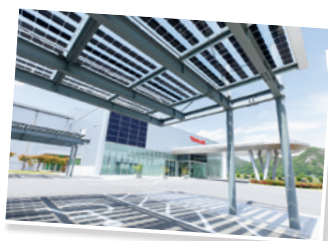
屋根に採光型の太陽光発電パネルを設置し、木漏れ日を連想させる駐車場
