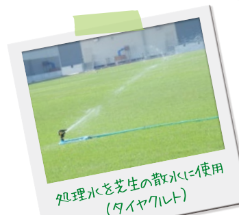
排水処理水を緑地への散水に利用 (メキシコヤクルト)
