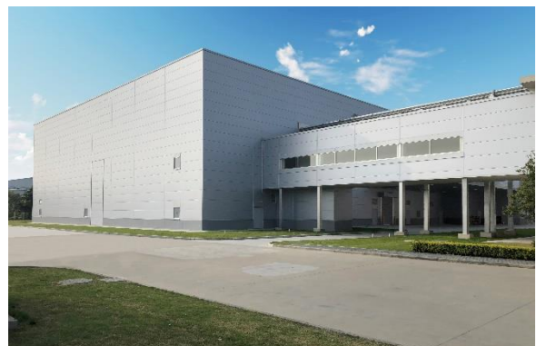
無錫工場第2工場棟 外観
